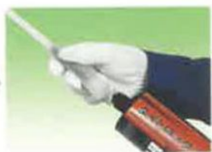
カートリッジにノズルをしっかりと締め込む
